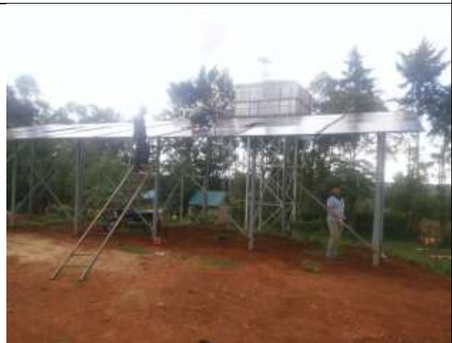
【写真 4】Shikangania 村の井戸にソーラパネルを設置して電気料金を下げ、安価な水の供給を実現。画面右下は、本会本部スタッフ（岡田）。(2017 年 3 月)
