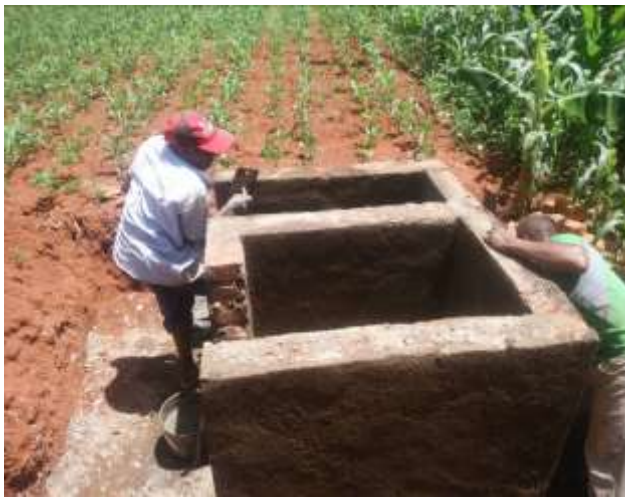
【写真 1】エコサントイレを建設するビルダーたち。一基の建設に対し通常 2 人のビルダーが作業に当たる。建設期間は 8～10 日間。(2017 年 4 月)
