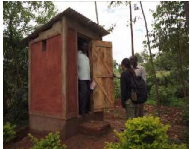
【写真 2】便槽部分を地中に埋めバリアフリー化したエコサントイレ。裏側に掘られた穴から肥料の取り出し口へアクセスが可能となっている。(2017 年 5 月)
