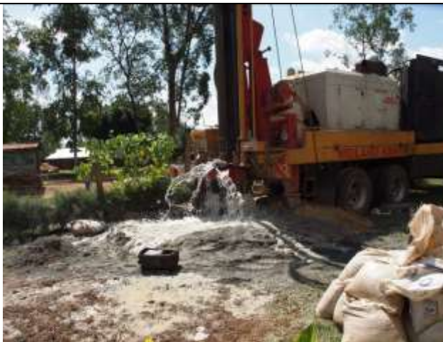
【写真 3】井戸の掘削工事。第 1 年次の 1 基に加え、第 3 年次にもう 1 基を Shilandaro 村に建設。さらに広い範囲への水供給が可能となった。(2017 年 5 月)
