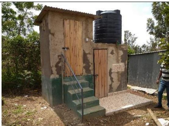
【写真6】住民負担建設のエコサントイレ。貯水曹、手すり、外付け手洗い場が取り付けられた。
