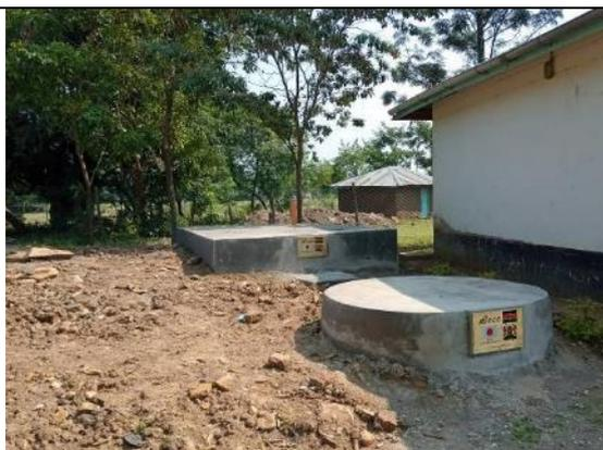
【写真2】完成した排水浸透枳（手前）と腐敗槽（奥）。[2020年7月、UHC]
