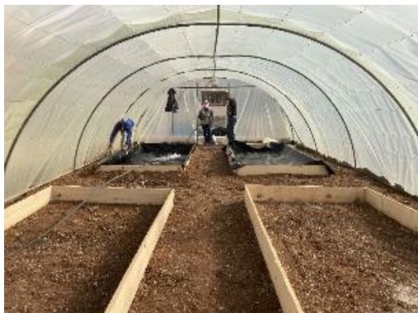
▲【写真1】建設途中の水耕栽培設備(2021年11月)
