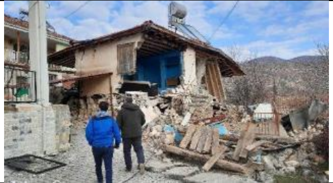
▲【写真 4】トルコ・アドゥヤマン県での調査の様子(2023 年 2 月)
