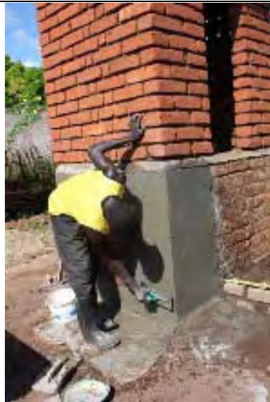
活動 68-②：エコサントイレ建設作業員スキルアップ再トレーニング(活動の様子 2)
