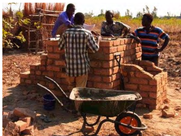
活動 69-②：新規エコサントイレ建設作業員トレーニング(活動の様子 2)
