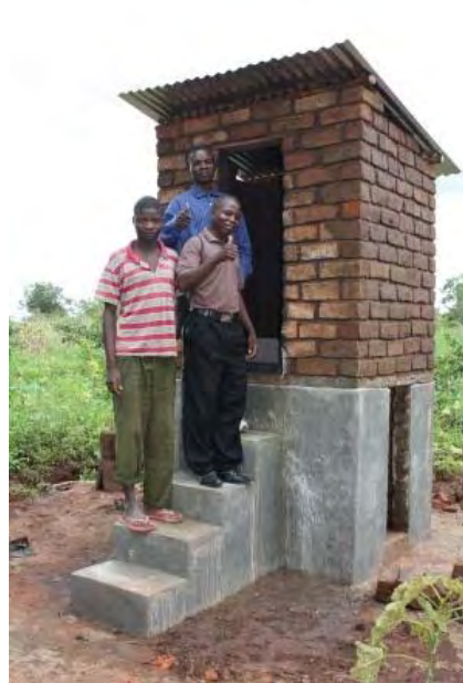
活動 67ー②：エコサントイレ建設(建設完了したトイレ)
