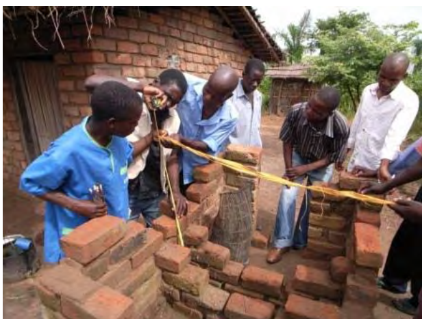
活動 65※ー①：エコサントイレ建設作業員スキルアップトレーニング(実地研修の様子)
