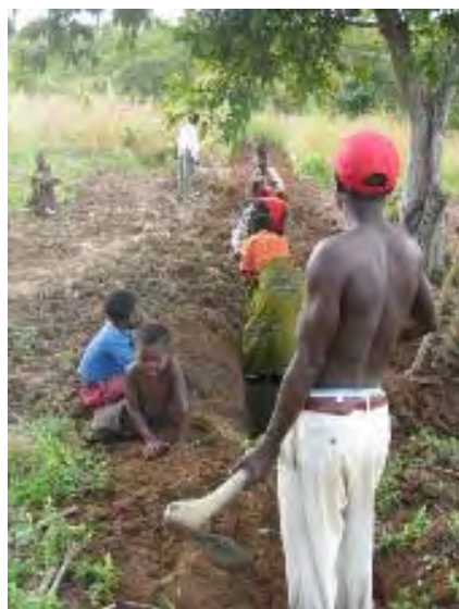
活動 59-①：水道建設(パイプ敷設用の溝掘り)
