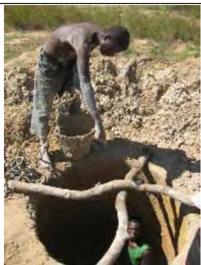
活動 58-①：井戸建設(井戸の掘削)
