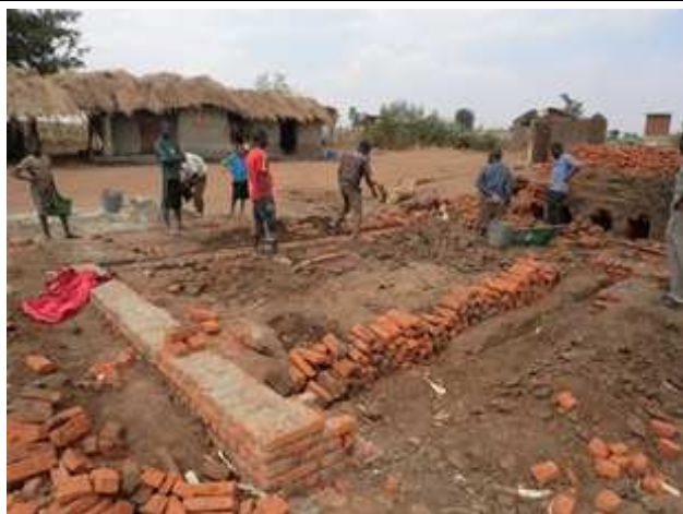
倉庫の土台作り
