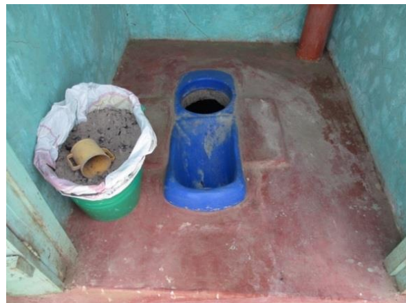
【8】エコサントイレ内部。バケツの中身は灰。
