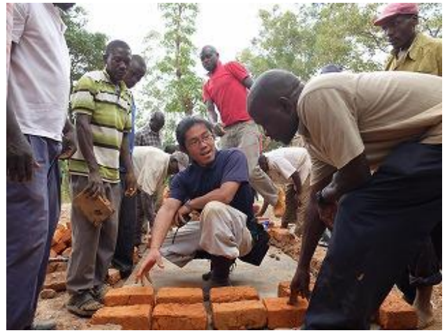
【写真2】エコサントイレのビルダー養成研修（実技） を行う江崎建築専門家（中央）。（2015年2月）
