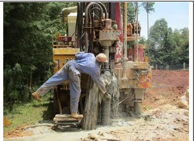
【写真 16】最初の水が噴出す様子。後日行った水質検査では、ケニア政府が定める水質基準を全項目で満たした。（2015 年 10 月）
