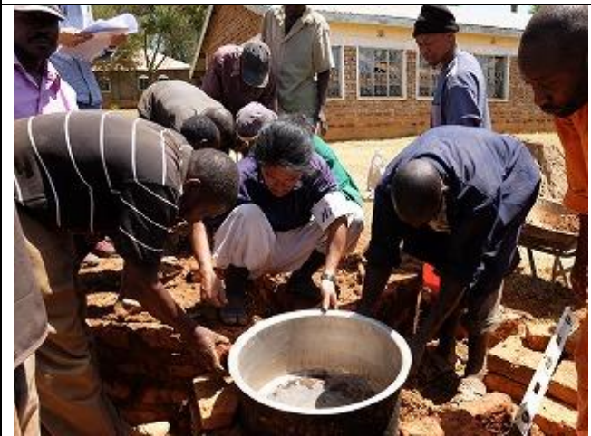
【写真 29】改良かまどのビルダー養成研修 (実技) を行う江崎建築専門家 (中央)。(2015 年 2 月)
