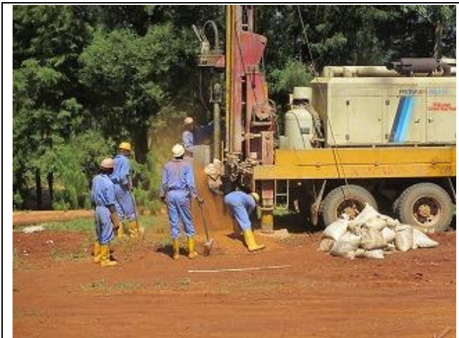
【写真 15】新規深井戸を採掘する様子。カカメガ郡にある建設会社が採掘を行った。（2015 年 10 月）
