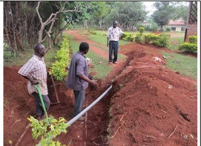
【写真 20】水道パイプラインの敷設。地元の配管工が作業を行い、約 1.0km の拡張を実施した。（2015 年 9 月）
