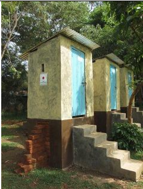
【写真5】ブシアンガラ小学校で完成したエコサントイ レ。（2015年2月）
