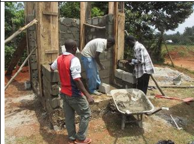
【写真 15】水キオスクの建設現場の様子。(2016 年 9 月)
