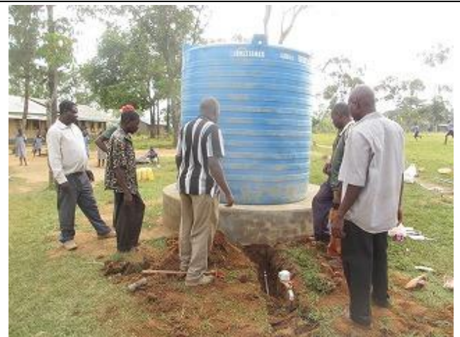
【写真 10】作業員が小学校に新規水道メーターを取り付ける様子。(2016 年 3 月)
