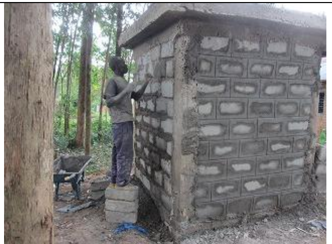
【写真 16】水キオスクを建設する作業員。事業地内に合計で 4 基を建設した (2016 年 10 月)
