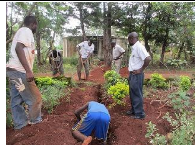
【写真 9】新規水道の敷設を行なう当会スタッフ (右) と作業員達の様子。(2016 年 3 月)
